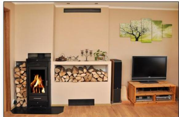
K vytápění rodinného domu je použit interiérový kotel **VERNER 13/10**, který je samotížně propojen s atypickou akumulační nádrží o objemu 500l. Díky samotížnému zapojení nevyžaduje kotel montáž vychlazovací smyčky.
