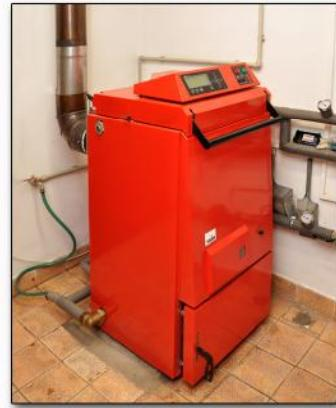
Rodinný dům je vytápěn nejmodernější generací zplyňovacích kotlů na kusové dřevo **VERNER V210 EXTRA** o jmenovitém výkonu 20 kW.
