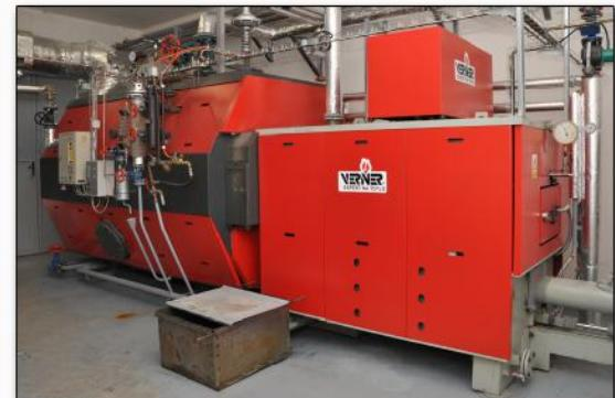
K vytápění výrobního objektu je použit **průmyslový kotel VERNER GOLEM 600** v parním provedení o jmenovitém výkonu 600 kW.
