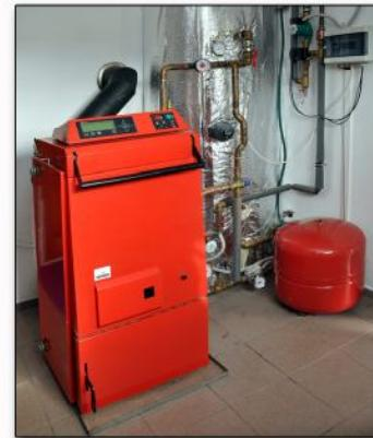
Nízkoenergetický rodinný dům je vytápěn nejmodernější generací **zplyňovacího kotle na kusové dřevo VERNER V140 EXTRA** o jmenovitém výkonu 14 kW.
