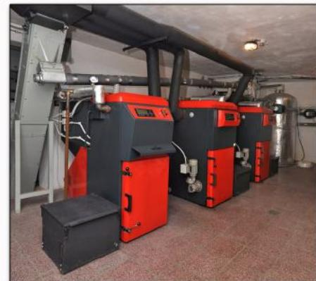
K vytápění penzionu je použita **kaskáda automatických kotlů VERNER** o celkovém výkonu 125 kW. Kotelna se skládá ze dvou automatických kotlů VERNER A501 a jednoho automatického kotle VERNER A251.
