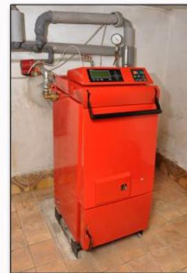
Dvougenerační rodinný dům je vytápěn nejmodernější generací zplyňovacích kotlů na kusové dřevo **VERNER V140 EXTRA** o jmenovitém výkonu 14 kW.
