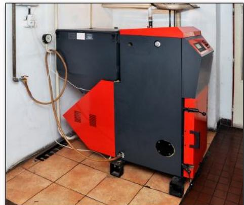
K vytápění rodinného domu je použit **automatický kotel na pelety, agropelety a obilí VERNER A251** o výkonu 25 kW.
