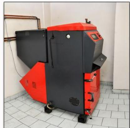
K vytápění budovy a k ohřevu teplé užitkové vody pro provoz dojírny je použit **automatický kotel VERNER A251** o jmenovitém výkonu 25 kW.
