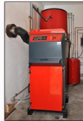
Ke komfortnímu a úspornému vytápění a ohřevu teplé užitkové vody rodinného domu je použit automatický kotel VERNER A251 na pelety, agropelety a obilí o výkonu 25 kW.
