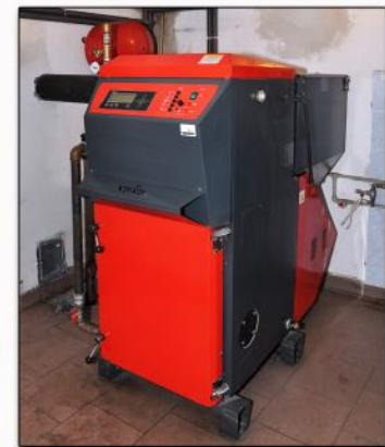
Ke komfortnímu a úspornému vytápění rodinného domu je použit automatický kotel VERNER A251 na pelety, agropelety a obilí o výkonu 25 kW.
